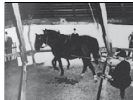
Húzatás szárazmalomban. A jobbágyoknak sorjában kellett benne a nagykereket körbe-körbe húzatniuk, forgatniuk – két-két lóval – az őrléshez. Mindez jó alkalomnak bizonyult az egymással való találkozásra, hírszerzésre is
